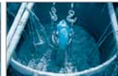
ข้อต่อทางสายไฟเข้าปั๊มแบบ Anti-wicking เพื่อป้องกันน้ำซึมเข้าสู่มอเตอร์ และขั้วสายเคเบิลตัว
